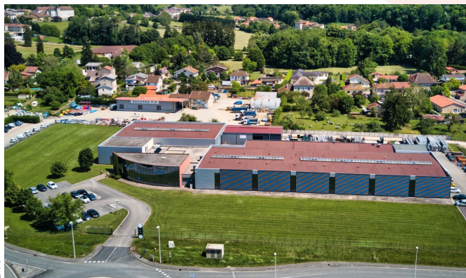
Usine de panneaux solaires hybrides DualSun à Jujurieux, dans l'Ain.
